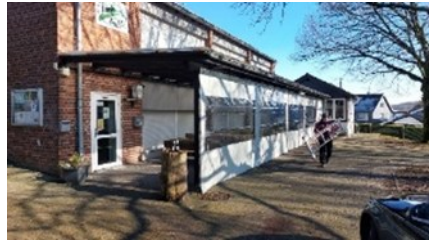
Pergola und Dach
